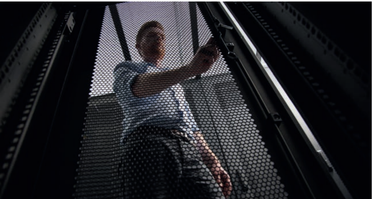
Zugriffskontrolle in einem IT-Rack
